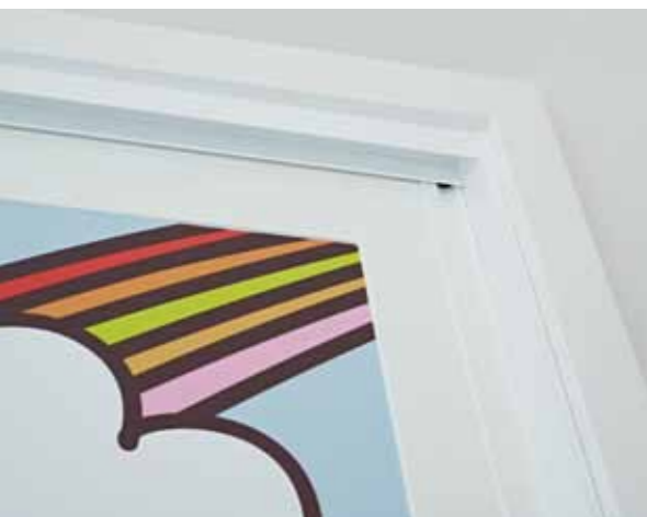
Guarnição 70x12 mm em melamina branca, com ângulo de 45° Tapajuntas 70x12 mm en melamina blanca, con ângulo de 45° Chambranles 70x12 mm en mélamine blanc, avec angle de 45° White melamine architrave 70x12 mm, with 45° angle
