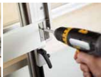
Fixação dos suportes da parede traseira
