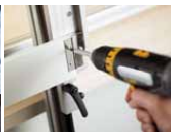
Fixação dos suportes da parede traseira
